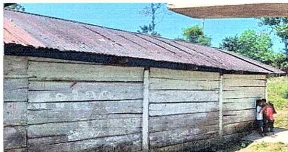
Foto 5: Aquí se muestra el deterioro de las láminas del salón y la pared de madera.
