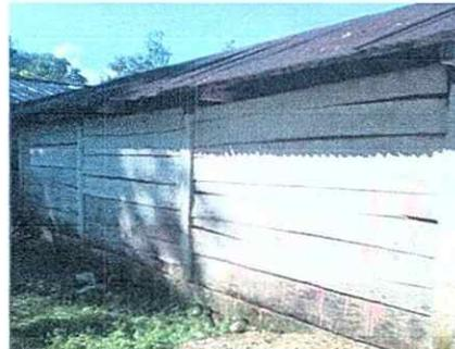
Foto 2: Aquí se muestra el mal estado de la pared de madera, parte externa.
