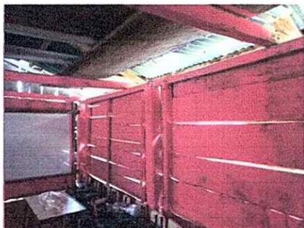
Foto 3: Aquí se muestra el deterioro de las láminas y vigas de madera de un salón.
